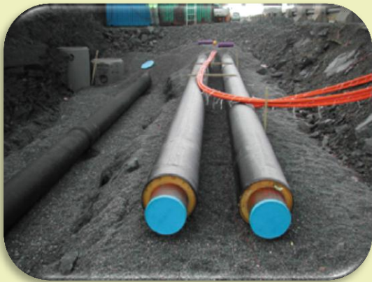
Fjernvarmerøyr. Kjelde: www.tu.no
