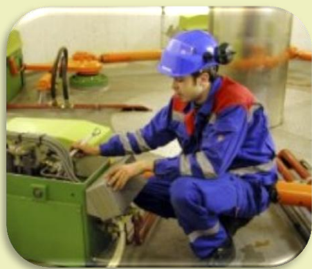
Vedlikehald i Naddvik kraftverk, Årdal Foto: www.idebanken.no
